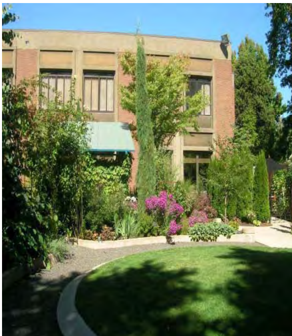
バーンユニットの外観
