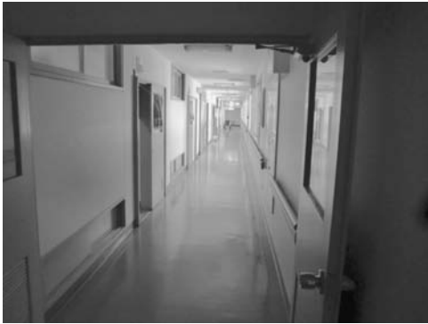
(写真3：避難場所と化した居室前の廊下)
