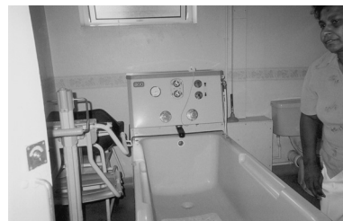
写真3 2階バスルーム
